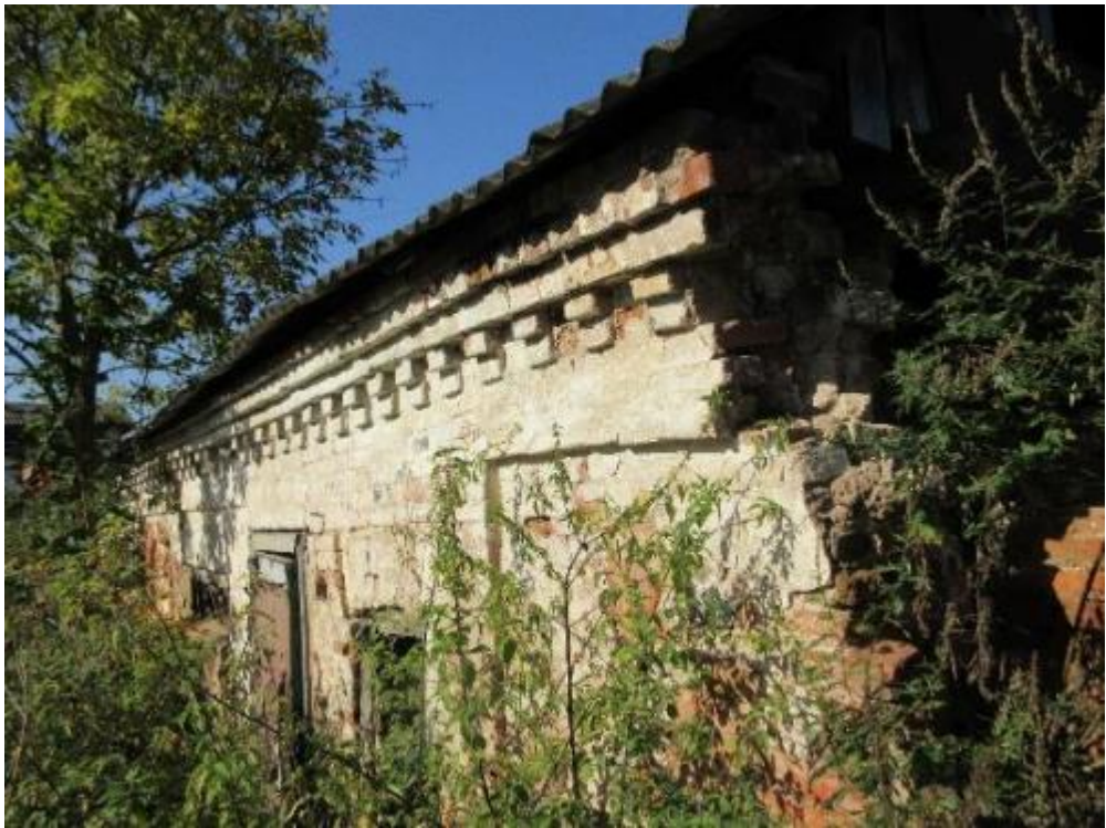
Фото 2. Конюшня. Северо-восточный фасад
