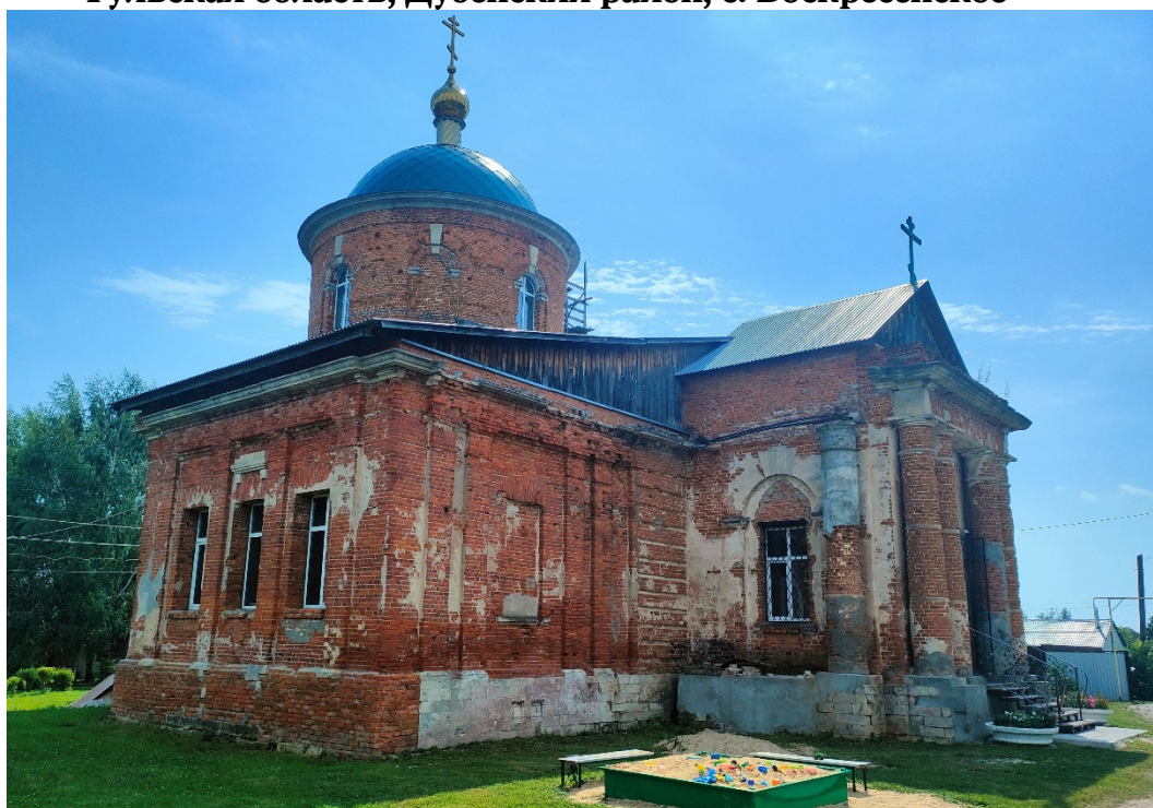
Фото 1. Вид с северо-запада
