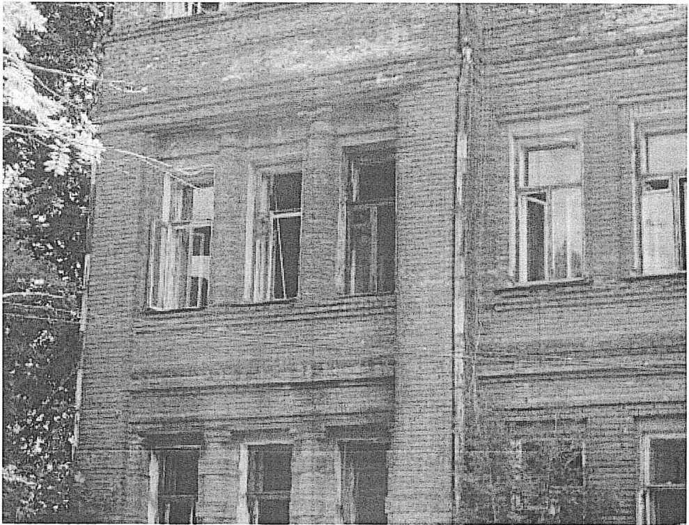
Фото 6. Фрагмент северного ризалита главного северо-западного фасада
