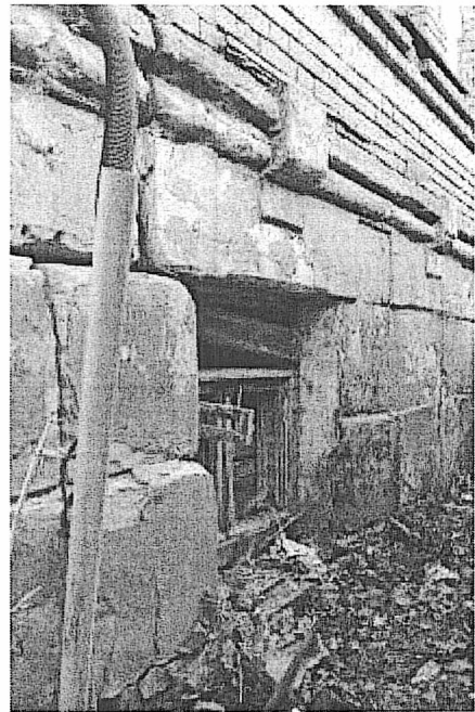
Фото 10. Фрагмент цоколя северо-восточного фасада
