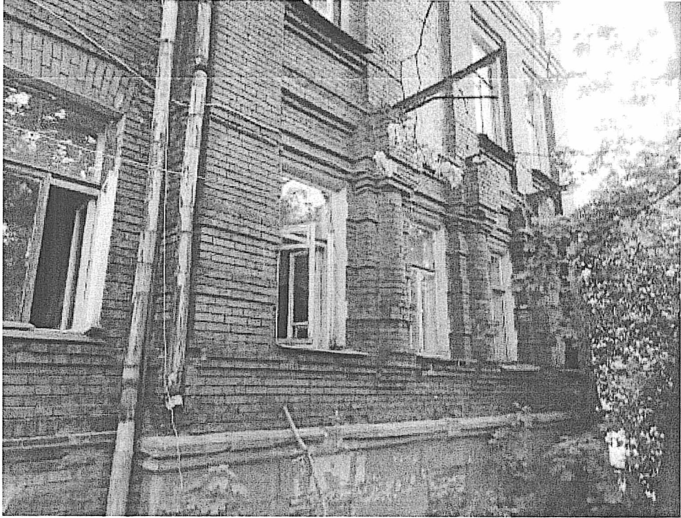
Фото 8. Фрагмент северо-восточного фасада
