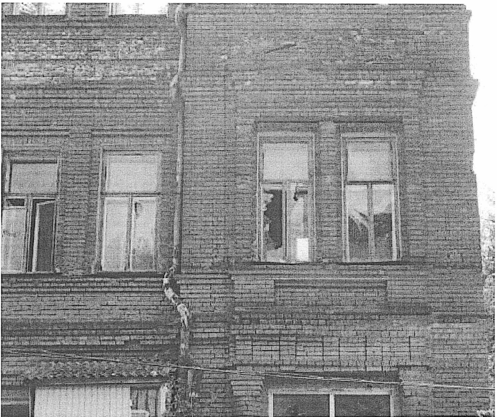
Фото 7. Фрагмент южного ризалита главного северо-западного фасада
