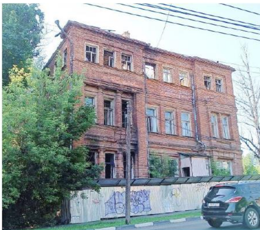
Фото 1. Вид с севера
